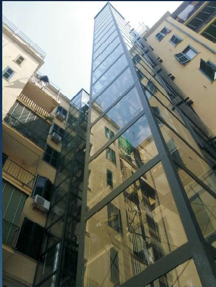
La competitività del progetto Vipal SpA si evidenzia grazie all'innovativo sistema di fissaggio della tamponatura che permette il filo liscio e continuo interno senza necessità di doppia pannellatura, conferendo alla struttura un aspetto pulito ed elegante anche internamente. Anche in questa soluzione si distingue la qualità Vipal SpA grazie all'utilizzo della lamiera zincata ed il trattamento della verniciatura a polveri.
